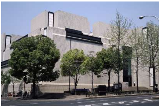
03 岡山市立オリエント美術館 (岡山市北区天神町9-31)
